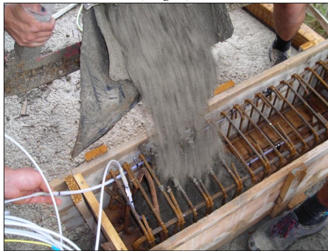
FIGURA 6 - Trave: getto del calcestruzzo
