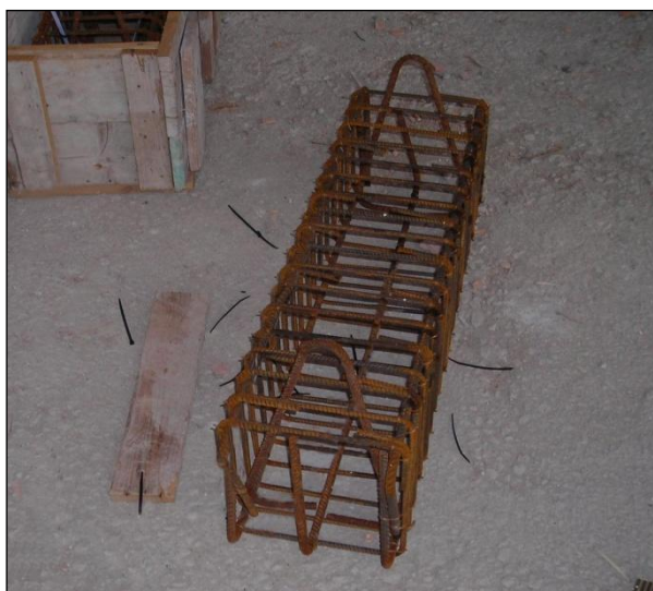
FIGURA 3 – Armatura prototipo di trave
