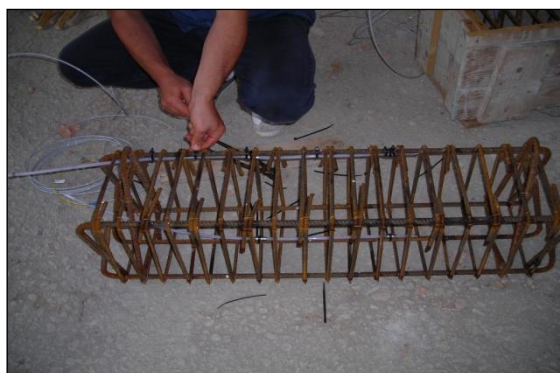
FIGURA 5 - Trave: fase di montaggio delle due fibre ottiche
