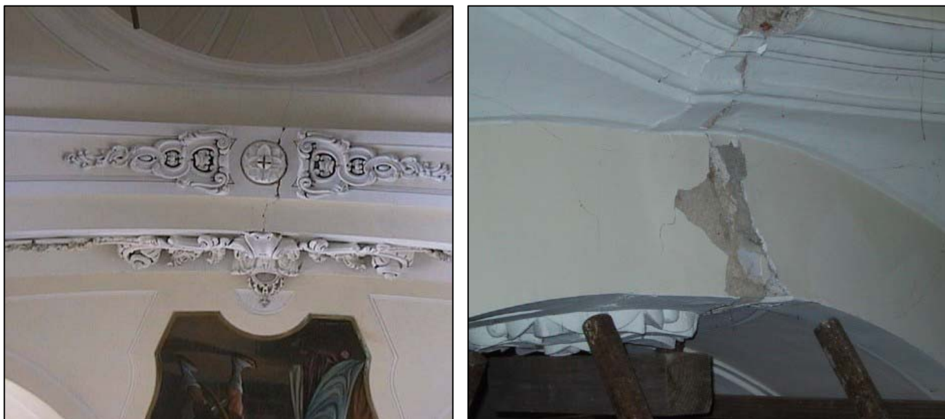
Fig.5,6 - Fessure sugli archi
